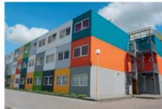
Prédio fabricado com contêineres de carga.
